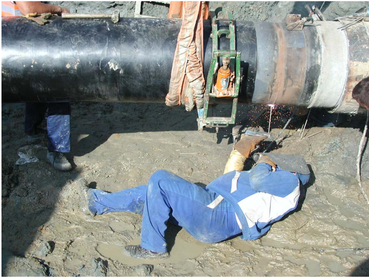
Slika 6. Zavarivanje radne cijevi koja dolazi iz uvodne cijevi kroz riječni nasip (desna strana) sa radnom cijevi koja ide min. 1,5 m ispod riječnog korita rijeke Česme (lijevo).
