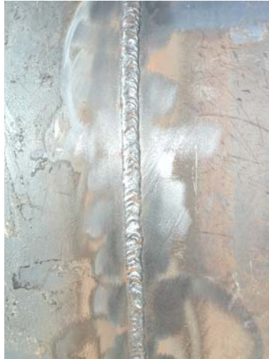
Slika 8. Izgled zavarenog spoja sa strane lica zavara izveden silaznom REL tehnikom zavarivanja uz korištenje celulozne elektrode.
