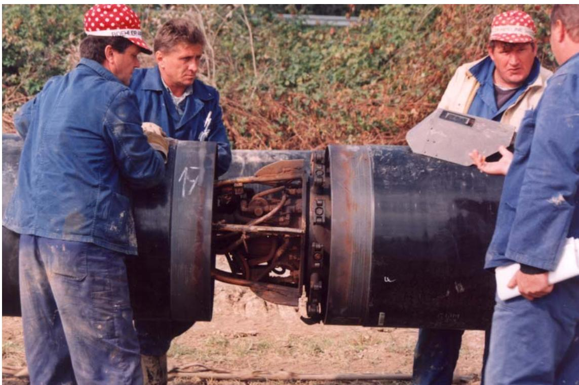
Slika 5. Detalj pozicioniranja čeličnih plinovodnih cijevi neposredno pred zavarivanjem
