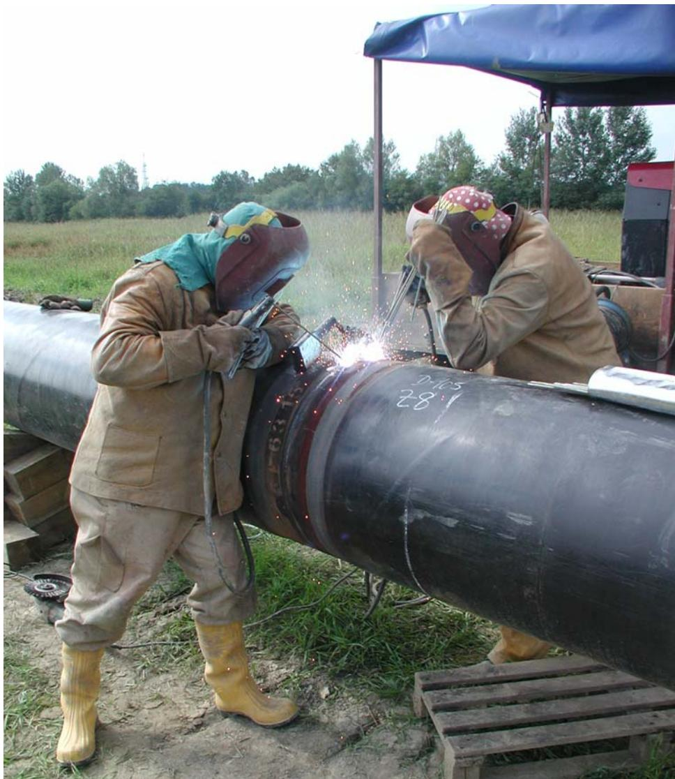
Slika 7. Detalj zavarivanja čelične plinovodne cijevi «fallnaht tehnologijom».
