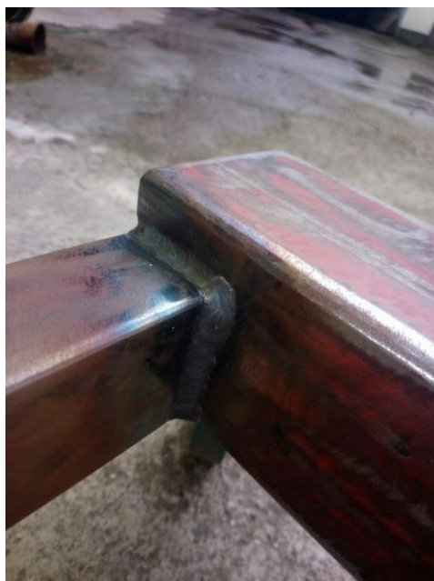
Figure 12. Zavar cijevi postolja
