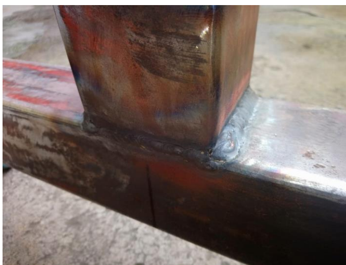
Figure 11. Zavar središnjeg stupa i postolja
