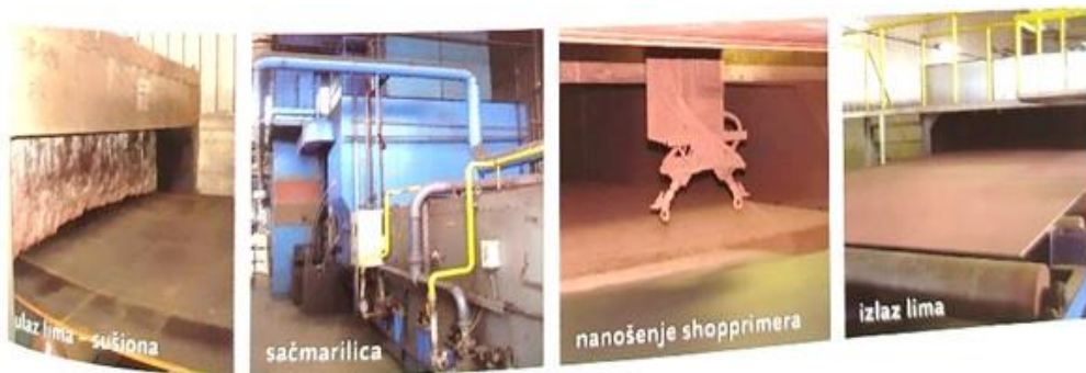
Slika 3.1 Radionica za privremenu radioničku zaštitu, Brodogradilište Uljanik [21]
