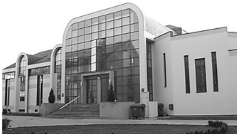
1. Zgrada u kojoj se nalazi Nadbiskupijski arhiv u Đakovu
