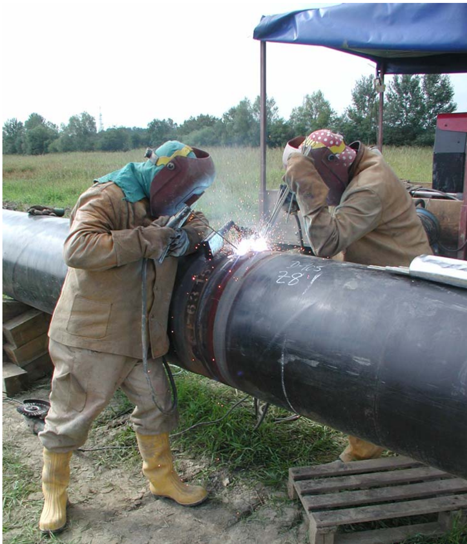
Slika 7. Detalj zavarivanja čelične plinovodne cijevi «fallnaht tehnologijom».
