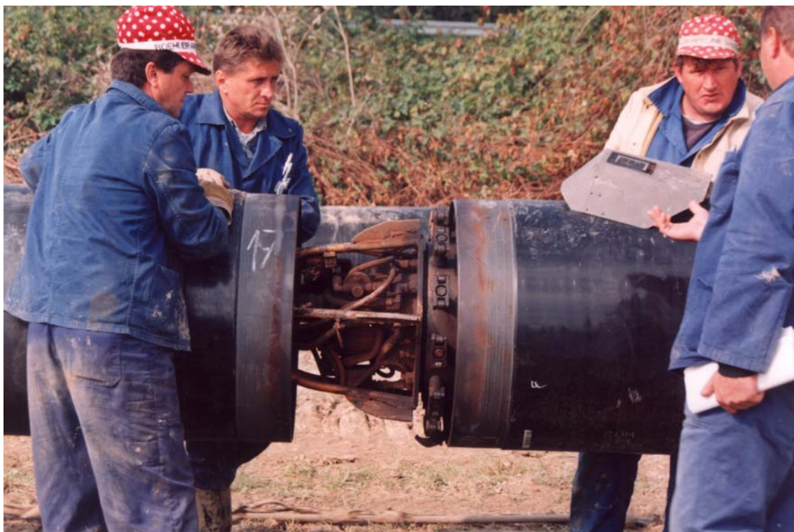
Slika 5. Detalj pozicioniranja čeličnih plinovodnih cijevi neposredno pred zavarivanje
