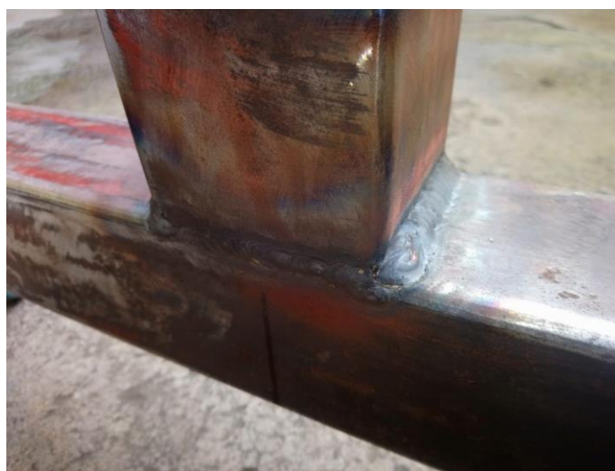
Figure 11. Zavar središnjeg stupa i postolja
