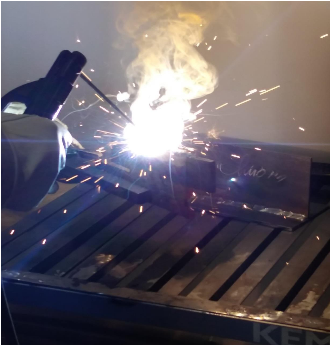
Slika 3.1 Prikaz REL tehnologije zavarivanja
