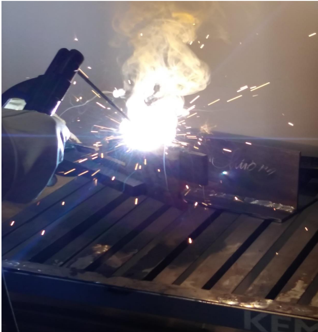
Slika 3.1 Prikaz REL tehnologije zavarivanja
