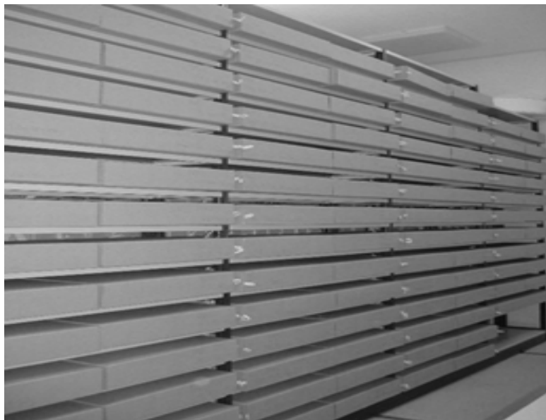
2. Smještaj parica u spremištu NAD-a
